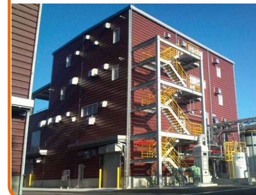
第一ファインケミカル 22工場 (7月完工)
