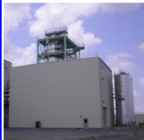
BIOKYOWA 新製造設備 (3月完工)
